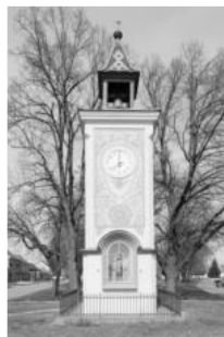
Rekonstrukce zvonice Uherský Ostroh
