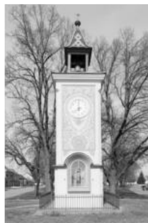
Rekonstrukce zvonice Uherský Ostroh
